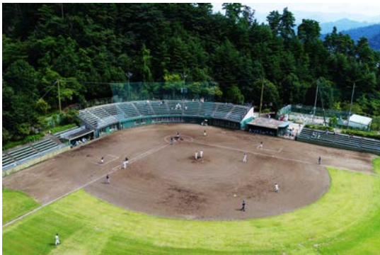
■改修工事を進めている楽山球場(ドローンにて撮影)
