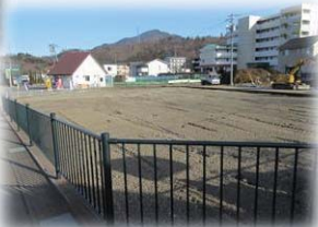
■現在造成中の代替地の様子
