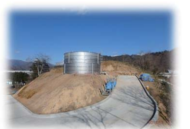
■現在、東部簡易水道第一配水池は造成工事中です。平成28年度は築造工事を実施します。
