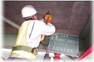
市道橋梁点検作業の様子
