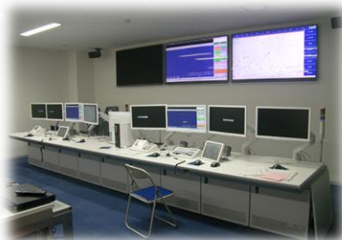
消防指令センター（写真は整備中のもの）
