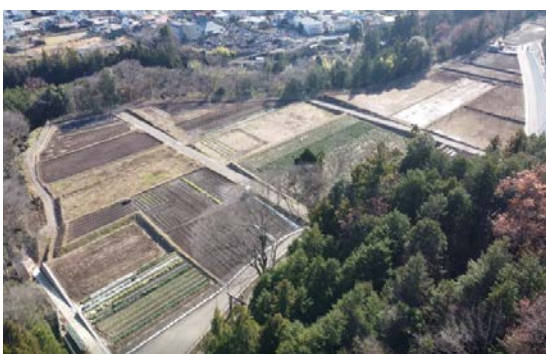
■ ほ場整備（川棚1工区）
