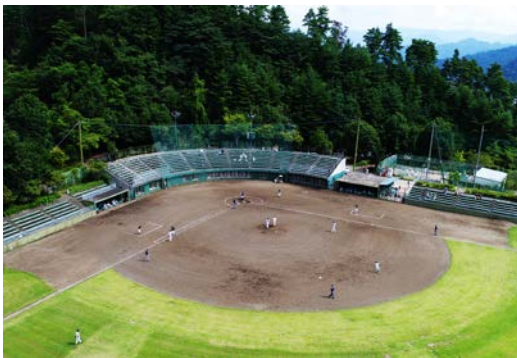
■改修工事を進めている楽山球場(ドローンにて撮影)
