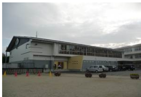
■ 谷村第一小学校体育館
