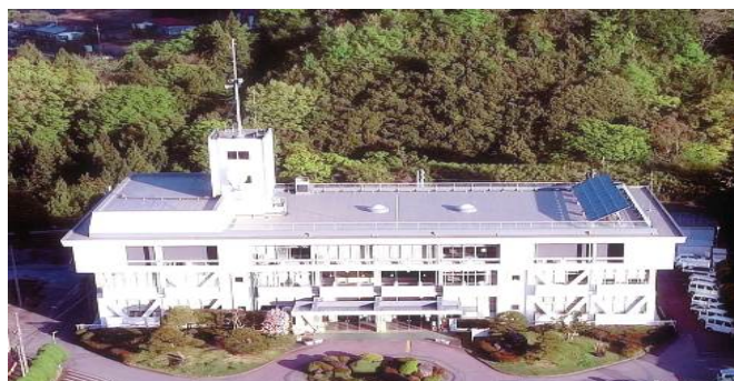
■市役所本庁舎に太陽光発電設置（非常用電源）
