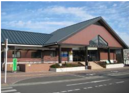
■ 都留文科大学前駅(田原土地区画整理)
