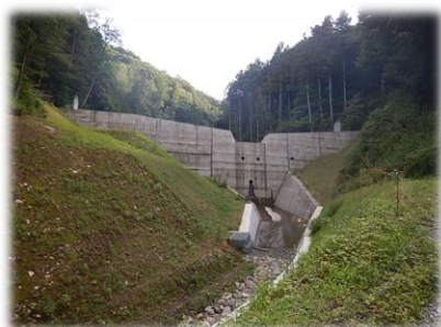
砂防堰堤工事
