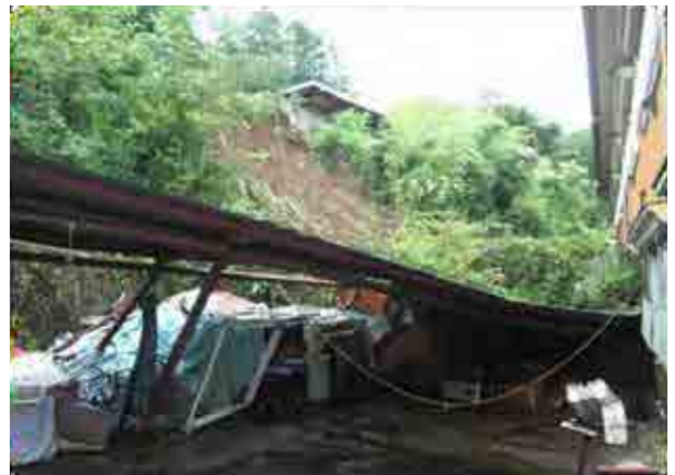
大雨によるがけ崩れ （平成 23 年 9 月台風 12 号）
