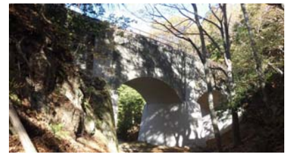
・ピーヤ（水路橋）
