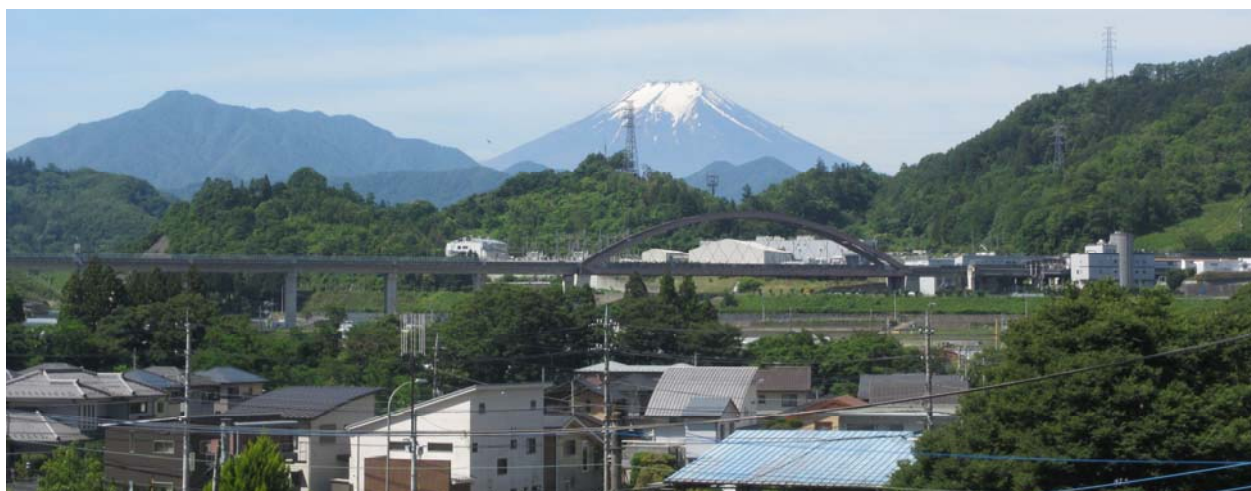
・リニア実験線小形山架道橋と富士山
