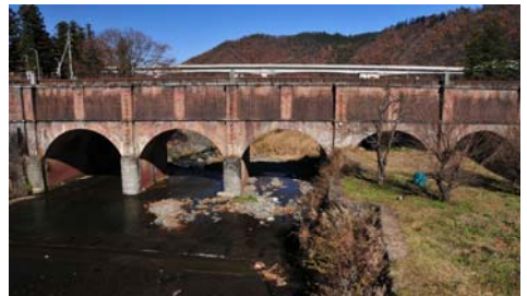
・駒橋発電所落合水路橋
