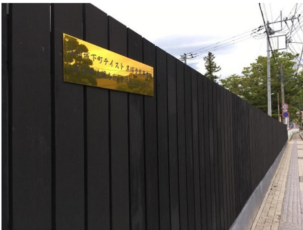
谷一小プールフェンス（黒塀設置）
