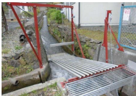
■夏狩地区に設置した除塵機
