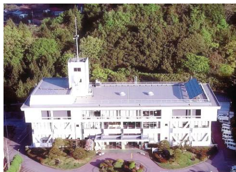
■ 市役所本庁舎に太陽光発電設置（非常用電源）
