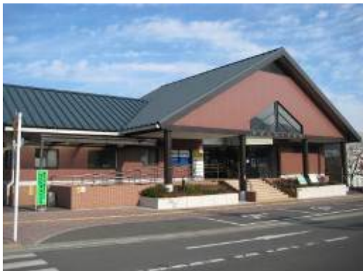
■都留文科大学前駅(田原土地区画整理)
