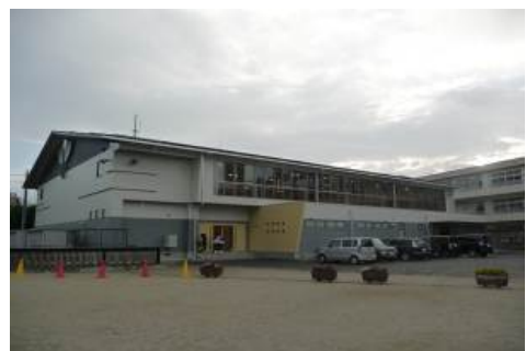
■ 谷村第一小学校体育館
