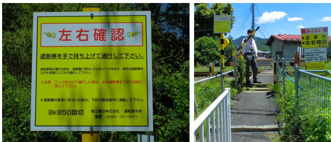
= 簡易遮断機（遮断機を手で持ち上げて通行） =
