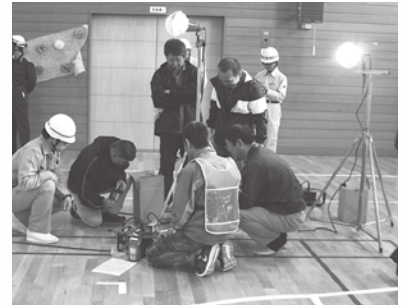
停電に備え、発電機・投光器を設置します
