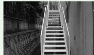
老朽化していた踏板を交換して、塗装もやり直したので安全に使用することができます。
