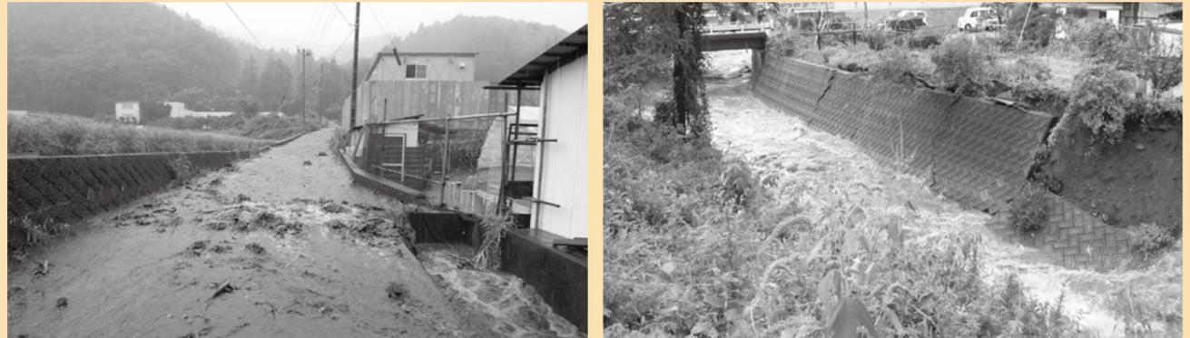
■(左)山から土砂混じりの水が流れだしている状況■(右)河川の氾らんによって護岸がひび割れ、崩れた状況(両方とも平成23年台風12号上陸時市内にて撮影)
