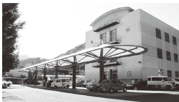
11月から2階の改修工事がはじまる「いきいきプラザ」
