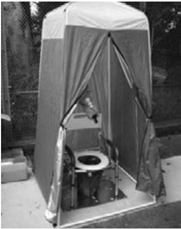
マンホールトイレ
