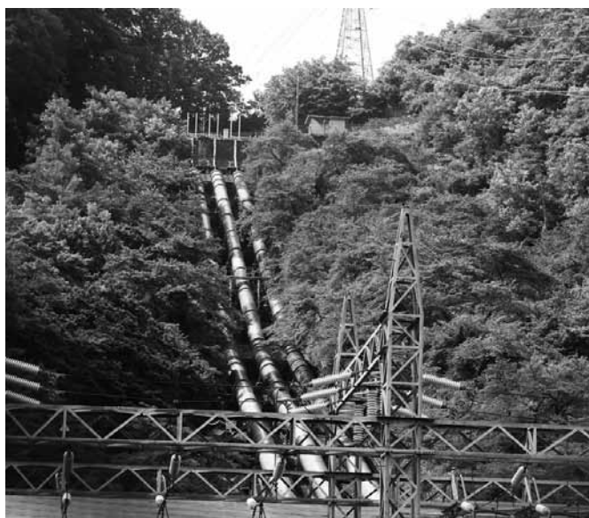
東京電力谷村発電所
