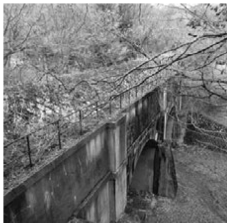
東京電力の水路橋
