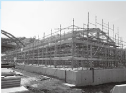
建設中の道の駅
