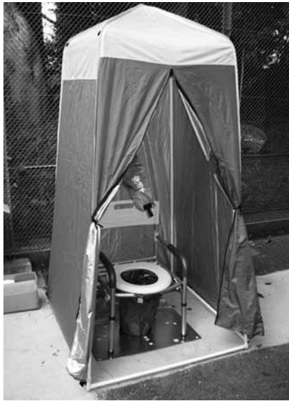
マンホールトイレ
