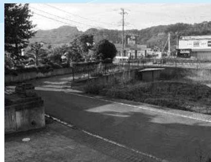
認定市道 「都留文科大学駅前通り線支線12号」
