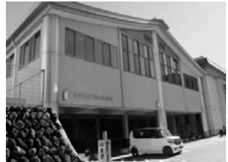
武道場の屋根復旧工事へ
