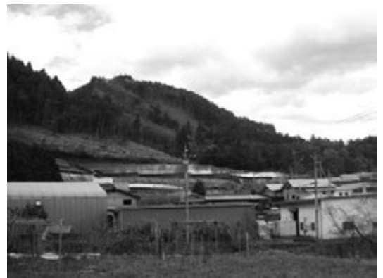
大幡地区に整備された太陽光発電設備
