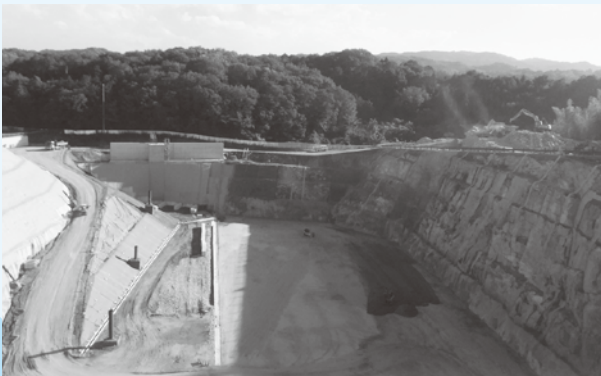
最終処分場現場（山全体が岩盤で汚染水の浸透・流出はない）
