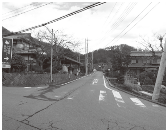
県道大幡初狩線入口
