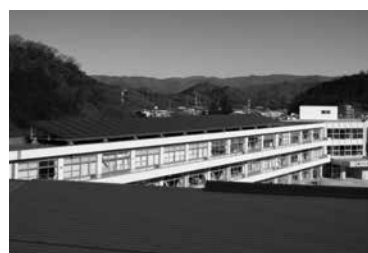
【公共施設の太陽光発電設備】
