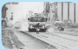
【道路】 ロードスイーパー による除去作業
