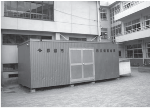
防災備蓄倉庫（谷一小校庭）
