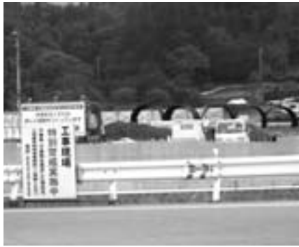
都留バイパス工事建設現場（玉川）
