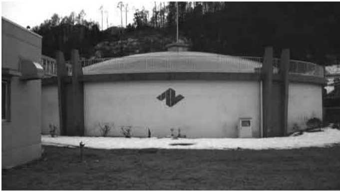
滝下浄水場配水池
