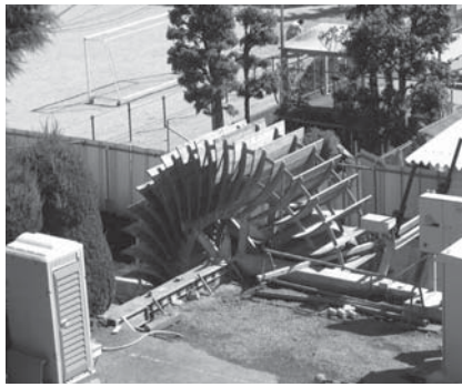
(10月13日現在建設中の家中川小水力市民発電所)
