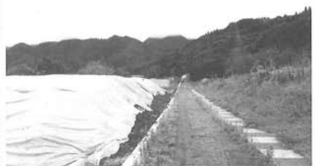
国道139号都留バイパス工事（井倉地内）
