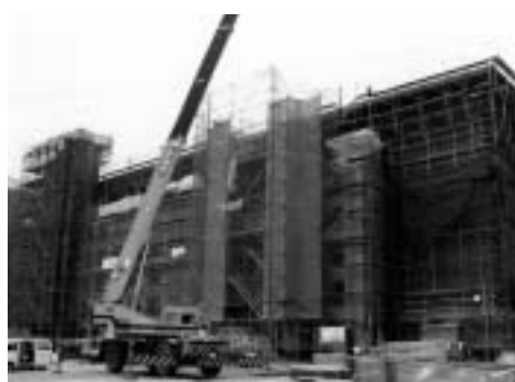
建設中の都留文科大学附属図書館
