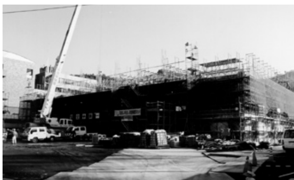
建設中の都留文科大学附属図書館
