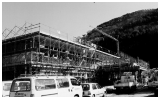
建設中の特別養護老人ホーム（東桂地内）
