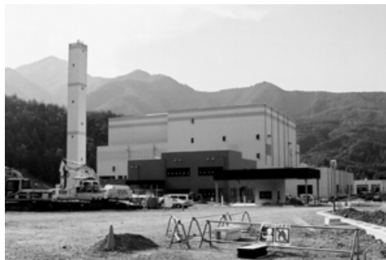
工事が進む大月都留広域事務組合
