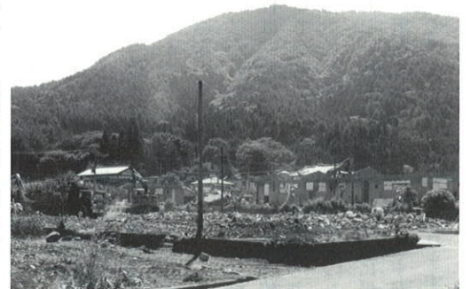
解体工事中の古渡住宅
