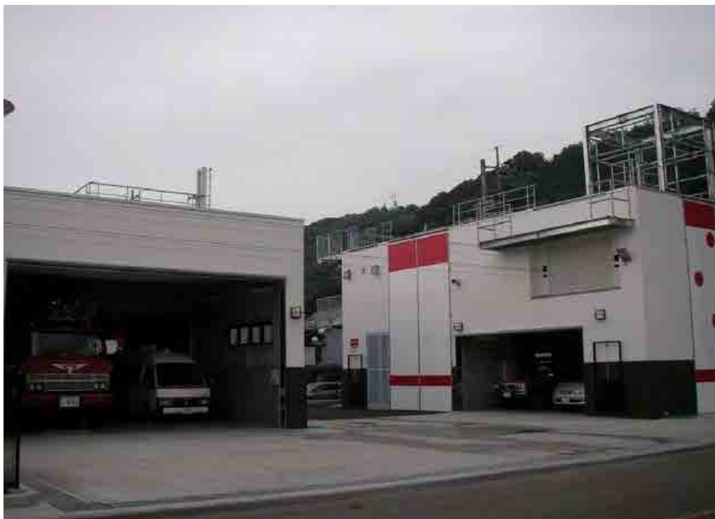
都留市消防署 訓練棟
