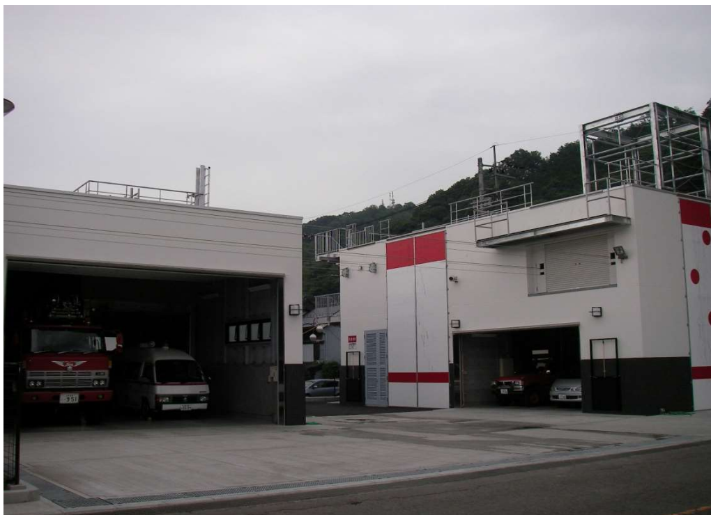
都留市消防署 訓練棟
