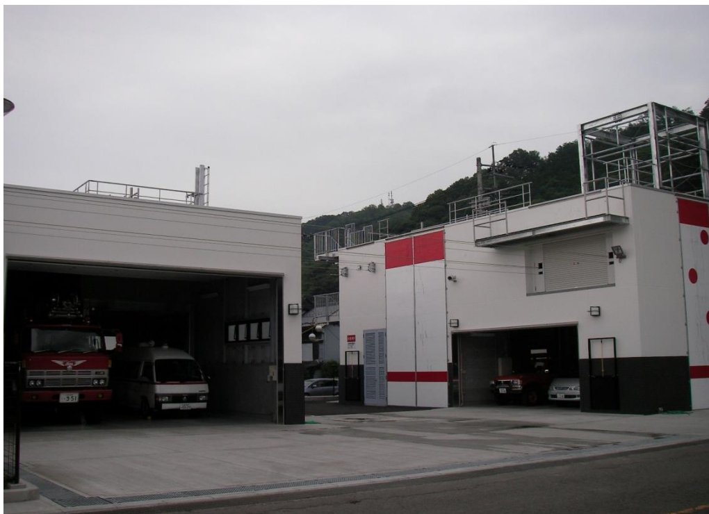
都留市消防署 訓練棟
