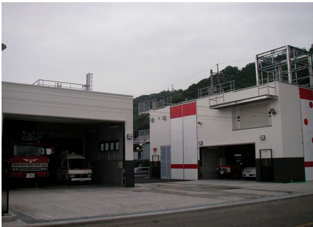
都留市消防署 訓練棟
