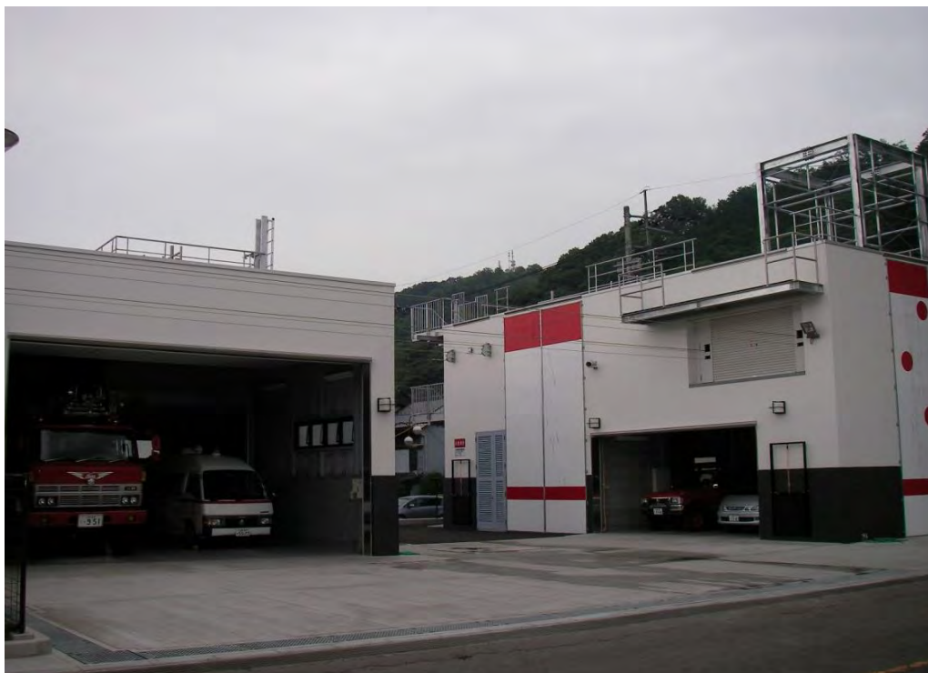
都留市消防署 訓練棟
