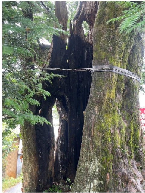
R5年度ブレーシングの様子
