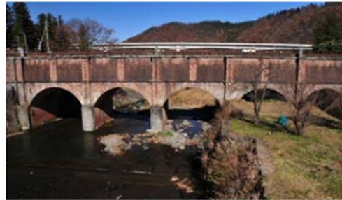
・駒橋発電所落合水路橋
