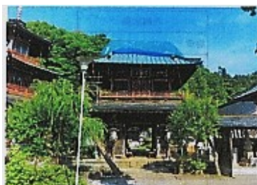
○外部状態 ブルーシート にて雨養生
