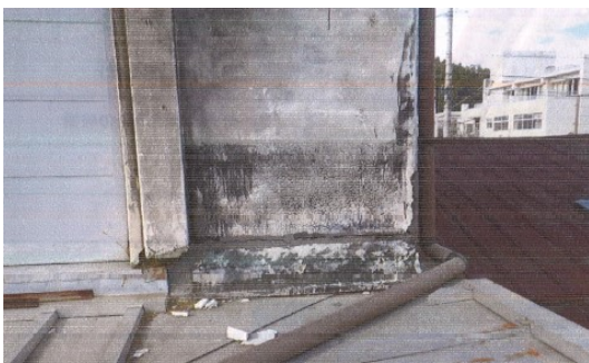
土壁の破損
