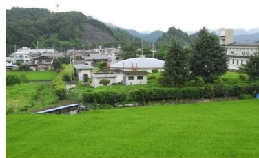
現在の滝下浄水場
