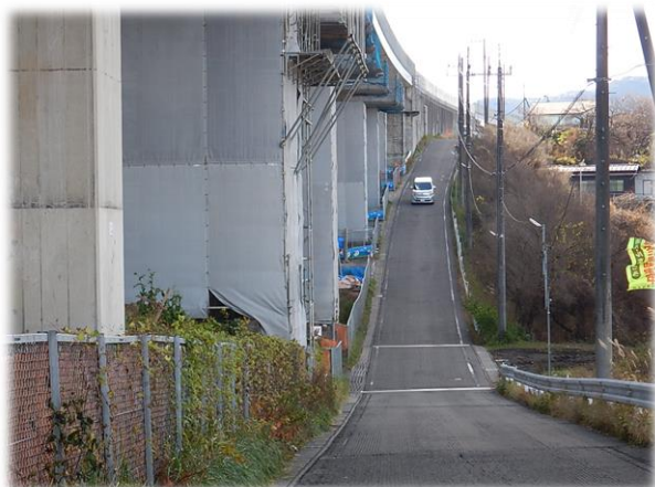
中央自動車道側道(幅員狭小)
