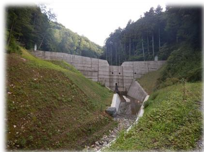
砂防堰堤工事
