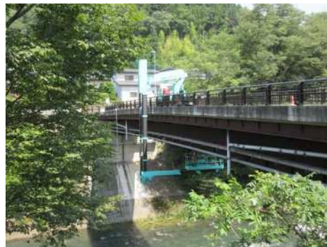
点検車による点検状況（川茂橋）
