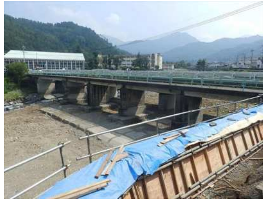
住吉橋（健全度Ⅲ）
