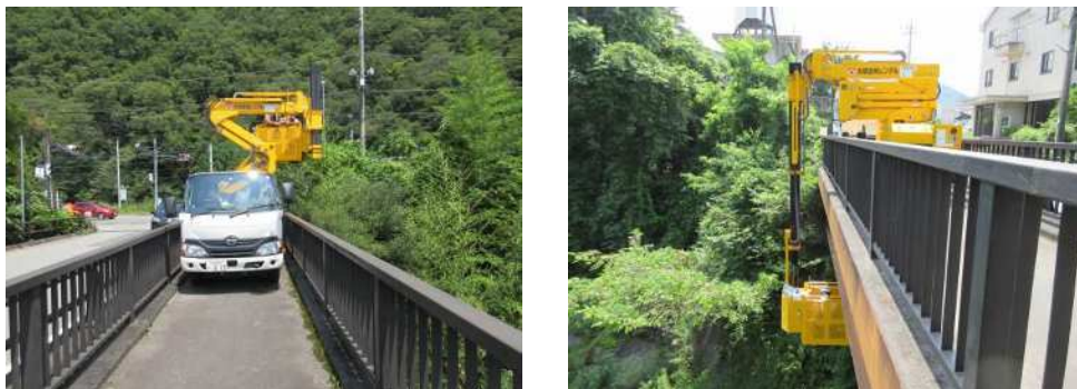
新技術活用事例 (車両設置幅 1.8mの道路施設点検車)
