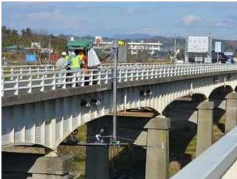
活用が期待される新技術の例（写真左：点検ロボット 写真右：ドローン）
