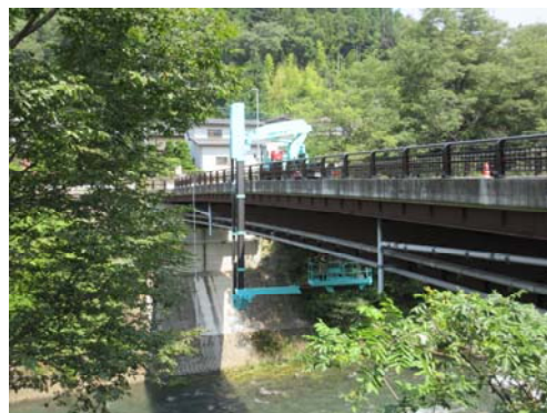
点検車による点検状況（川茂橋）
