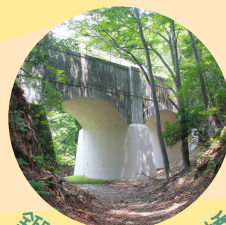
鍛冶屋坂水路橋
