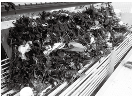
▲除塵機には、1日で草など大量のごみが堆積します。
